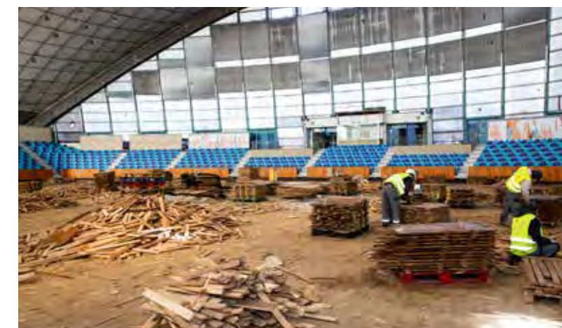
Dépose du parquet de la Grande Nef de l'Île des Vannes, en vue de son réemploi
