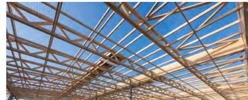
Travaux de charpente sur le Hall 3 du Parc des Expositions Paris-Le Bourget
