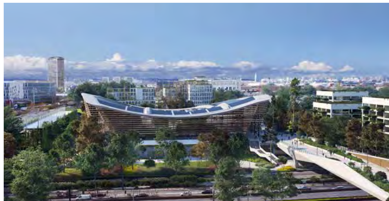
Panneaux photovoltaïques sur la toiture du Centre Aquatique Olympique
