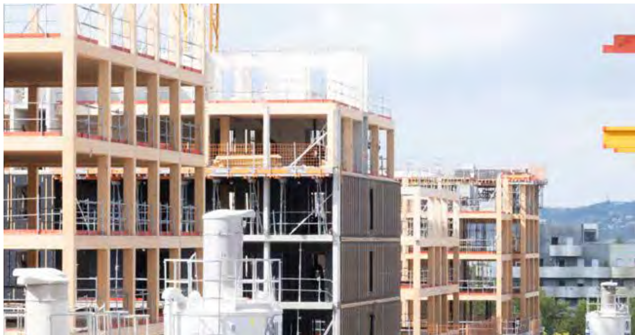
Mise en œuvre de façades à ossature bois (FOB) sur le secteur D du Village des Athlètes (Les Quinconces)
