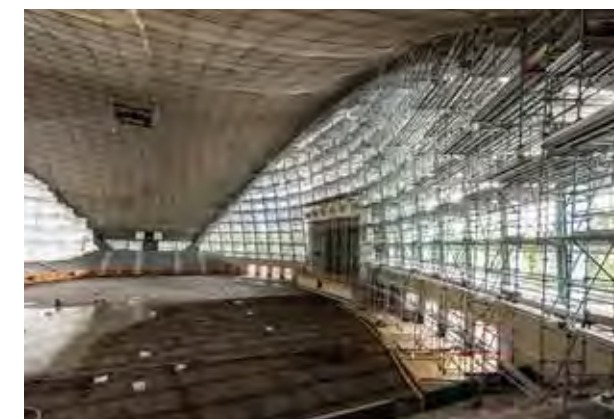
La Grande Nef de l'Île-des-Vannes à Saint-Ouen pendant les travaux de rénovation
