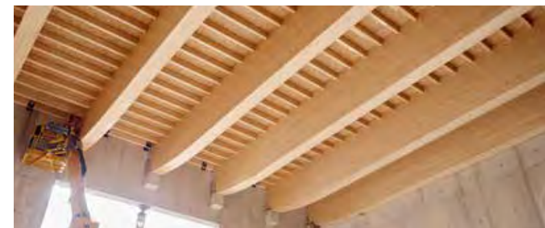
Charpente bois de l'Arena Porte de la Chapelle
