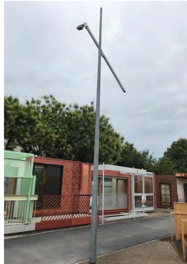
Mât d'éclairage issu du réemploi, fabriqué à partir d'éléments d'échafaudages en métal
