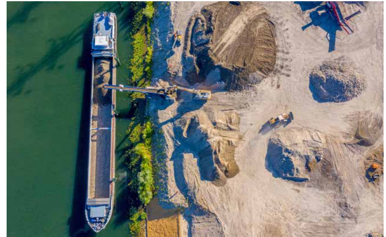
Évacuation des terres excavées par voie fluviale
